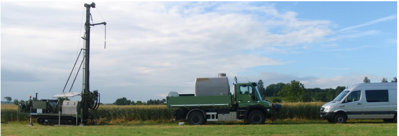
Abbildung 1: Aufbau des Bohrgeräts inkl. Unimog zur Wasserversorgung und Zubehörtransporter in der Flur.
